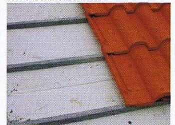
Cubierta con teja colocada
