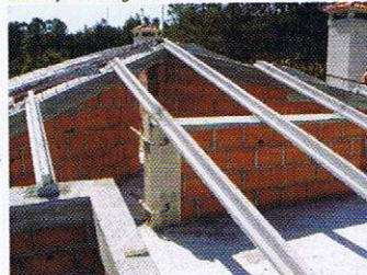
Colocación de las viguetas
