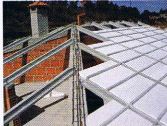
Colocación de los rastreles y placas EPS
