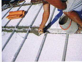
Colocación de la argamasa entre las viguetas y los rastreles
